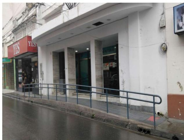
**Imagen** - Intervención en la vereda (rampas paralelas al sentido de la misma) para llegar a nivel de piso interior.
