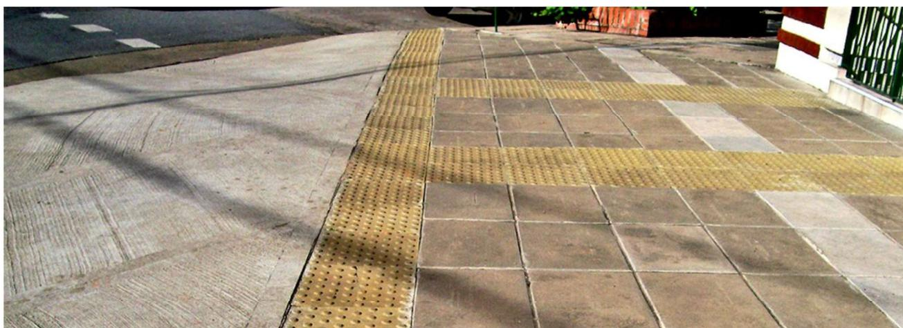
**Imagen** - Vado peatonal con superficie texturada (guía o banda táctil), C.A.B.A. Es prioritario que se incluyan en itinerarios de circulación en sectores de transporte público y en itinerarios de veredas que llevan a centros de servicios importantes.
